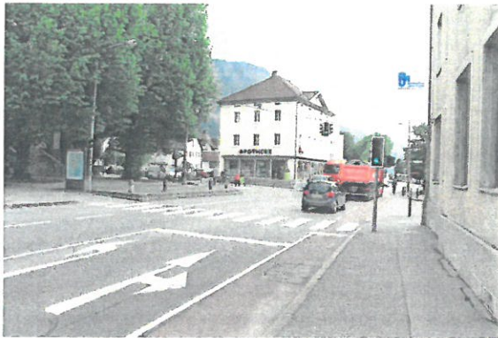
Gehsteig Kreuzung Leopoldstraße – FR Hohenems
